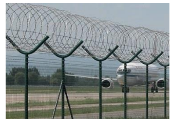
Pav. 9 JAUTRAUS ELEMENTO IŠDĖSTYMAS ANT PLOKŠČIOS SPIRALINĖS SPYGLIUOTOS VIELOS, SUMONTUOTOS VIRŠ TVOROS.
