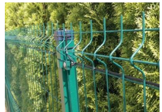
Pav. 1 JAUTRAUS ELEMENTO IŠDĖSTYMAS ANT LENGVOS SUVIRINTO TINKLO TVOROS
